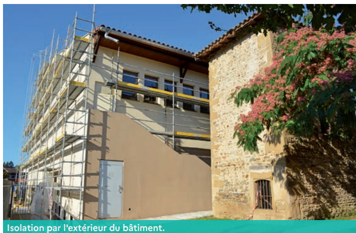
Isolation par l'extérieur du bâtiment.
